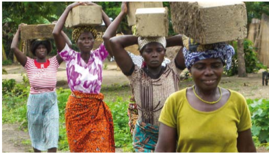
Frauen aus Abouzokope tragen Steine für den Bau des Versammlungshauses zur Baustelle.
